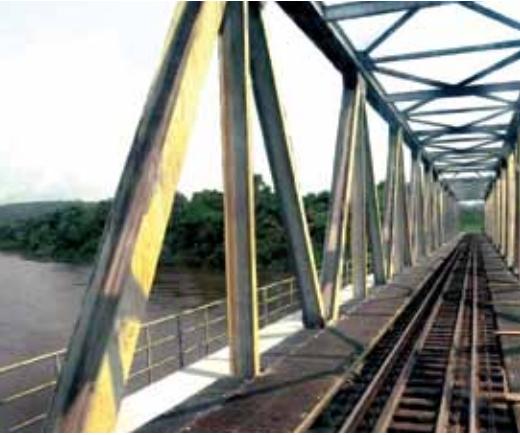
Ouvrage d'art du Transgabonais
