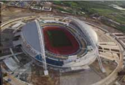
Stade de l'amitié de Libreville en construction
