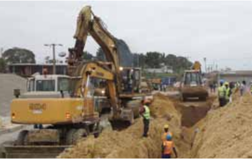
Pose d'une canalisation d'eau
